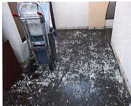
d. Remoción de piso y alfombra e instalación de nuevo piso en la oficina de Rectorado
