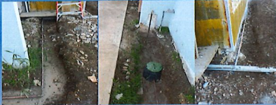
Tubería de agua potable
